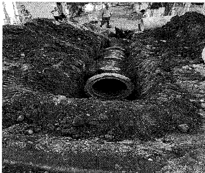
Assentamento tubulação de 800mm
