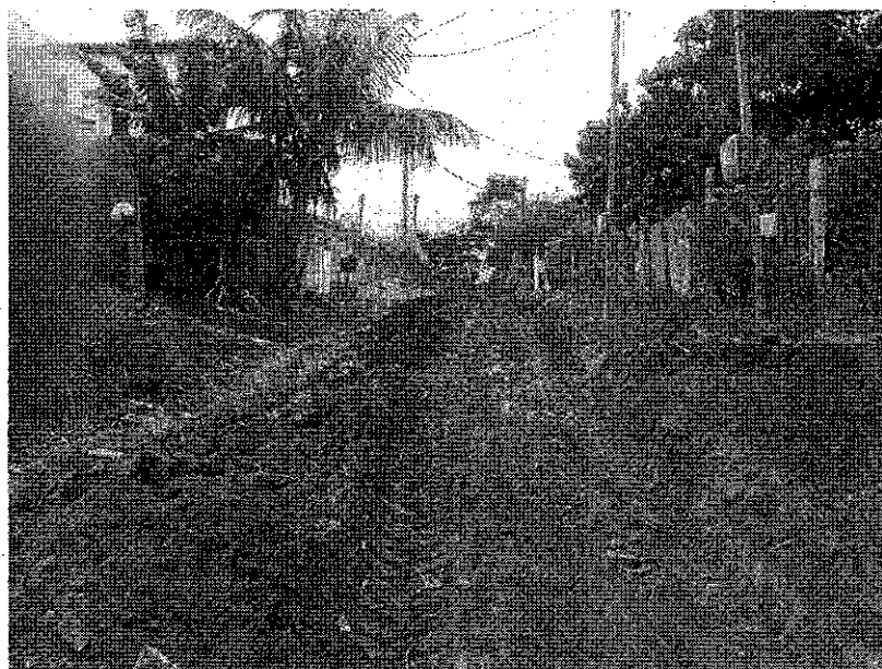
Preparo de Terreno
