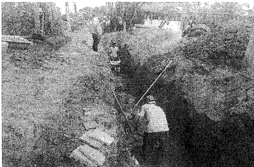
Assentamento e Embasamento de Tubulação.
